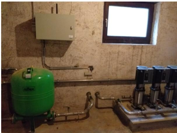
Pumpenanlage mit Druckwindkessel und Stromanschluss
