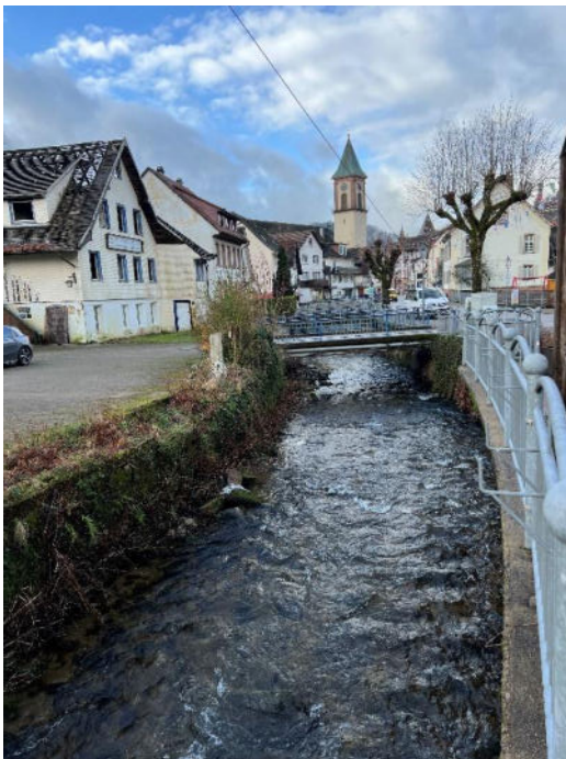
Abb. 26 Uferbereich Rench / Schwarzwaldstraße
