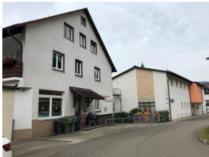
Abb. 32 KiGa St. Bernhard (links) und KiGa-Nebengebäude „Wetzelshaus“ (rechts)
