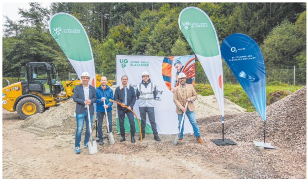
Im Foto von links: Bürgermeister Meinrad Baumann, Bau- und Liegenschaftsamtssleiter Markus Waidele, Pavel Forman (Oberbauleiter), Fabian Hoyer (Regional Deployment Manager), Rupert Metzler (Senior Expansion Manager UGG).
